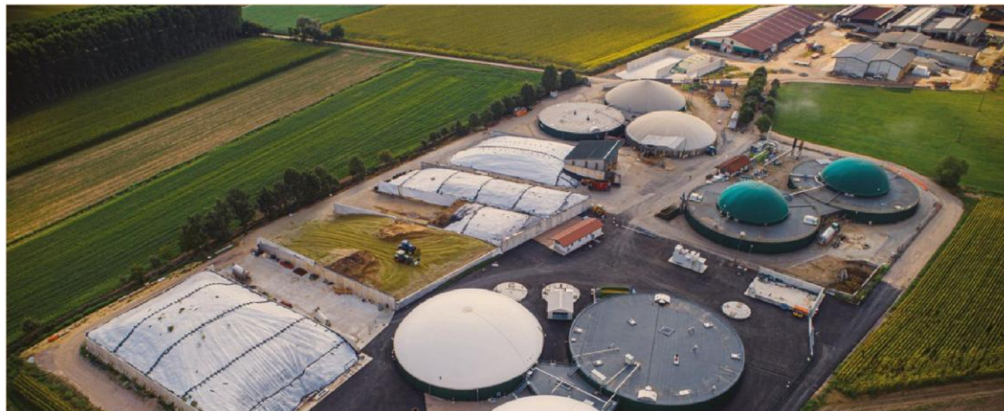
Attività. L'azienda è anche al lavoro per trovare soluzioni che possano contribuire a mitigare l'impatto odorigeno generato dagli impianti di depurazione delle acque reflue
